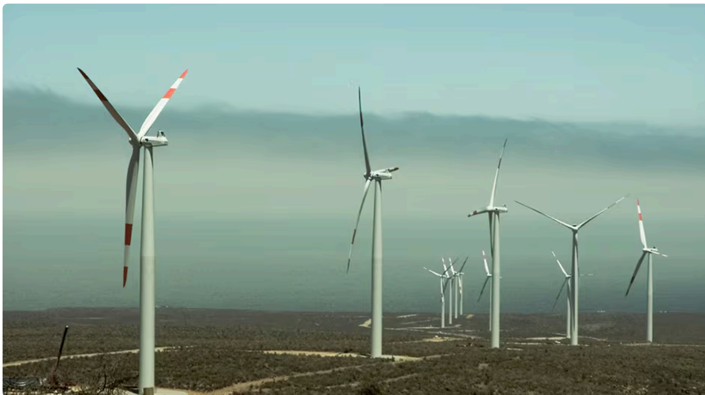
Luz del Sur opera tres parques eólicos en el sur del país. En la foto el parque "Tres Hermanas", ubicado en Ica.
